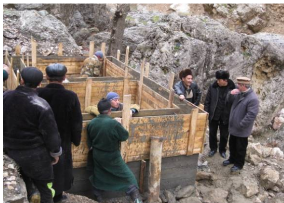
Строительство системы питьевой воды в Ёри, Пянджикент | GTZ
